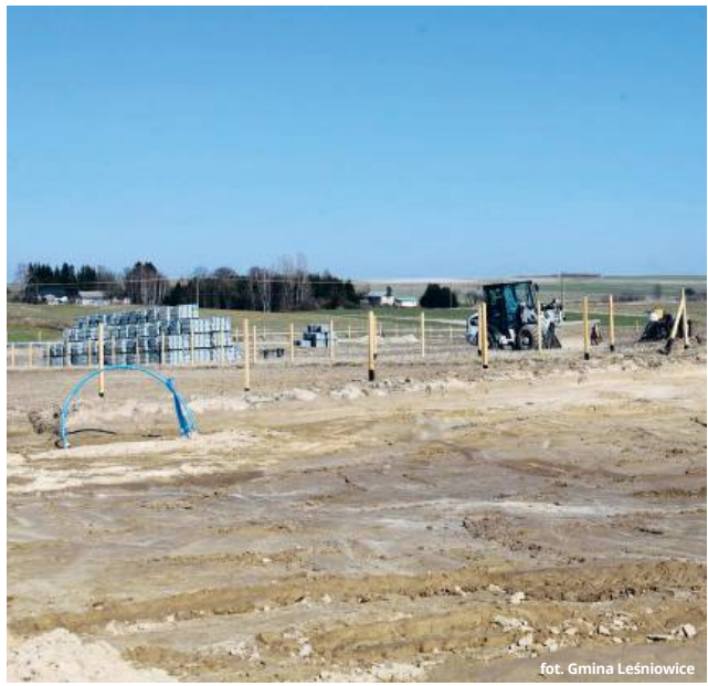
Budowa budynku, który będzie spełniał funkcje kulturalne, już została rozpoczęta. fot. Gmina Leśniowice
