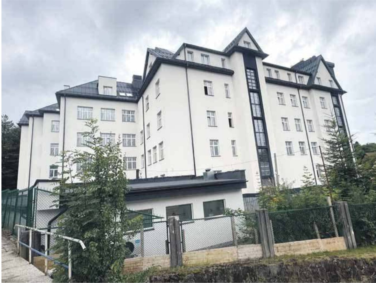
Budowa nowego gmachu rabczańskiego szpitala dobiega końca.
