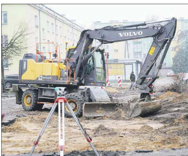
Roboty budowlane na ul. Sikorskiego ruszyły. Podobnie jest na Morelowej. Te inwestycje były zaplanowane na 2022 rok
