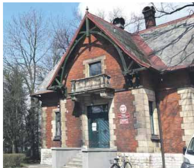
Budynek stoi tuż przy głównym wejściu do parku
