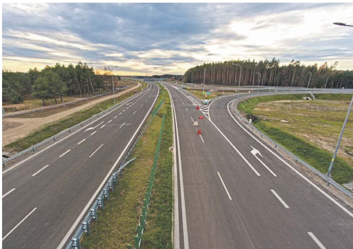
Długość odcinka S19 Rudnik nad Sanem – Nisko Południe to 6,46 kilometra
