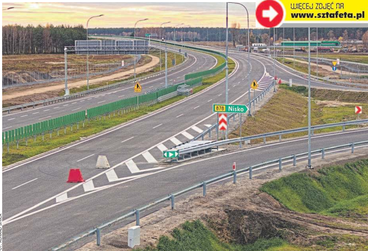
Widok z wiaduktu przy węźle „Nisko Południe”
