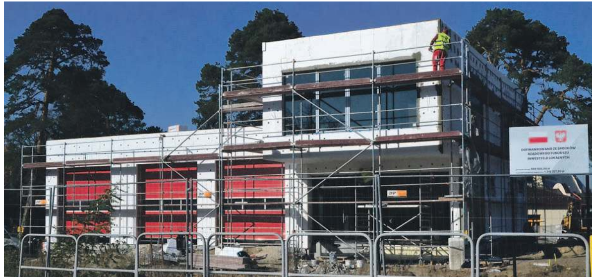
Prace przy budowie remizy powinny zakończyć się jeszcze w tym roku
