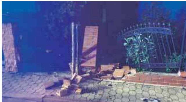
Bilans brawurowej jazdy to 4 uszkodzone ogrodzenia FOT. ARCHIWUM OSP ŚWIERKLANIEC
