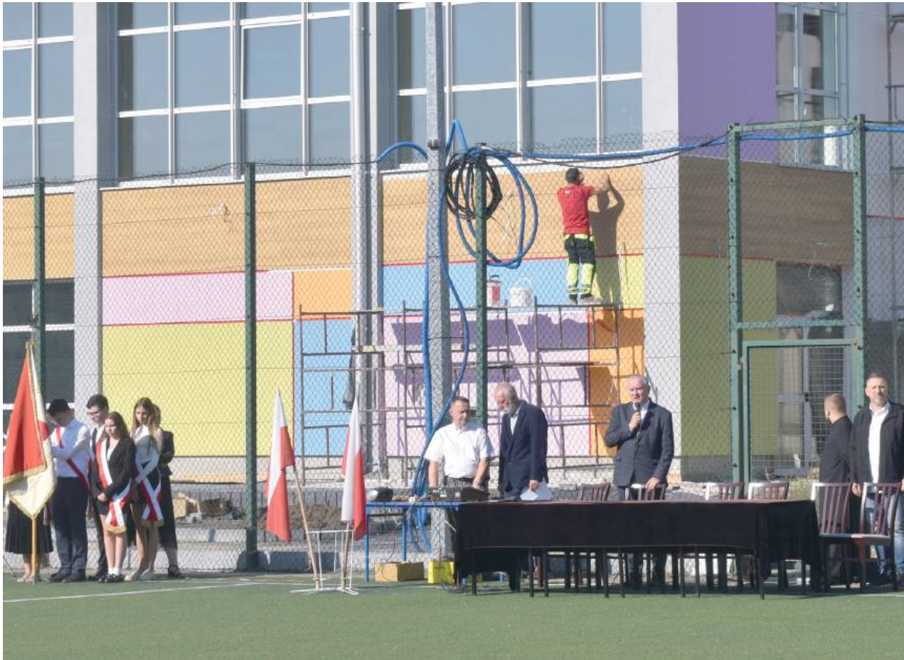
Dyrektor Marian Kurzyna witał uczniów na tle prac budowlanych. Centrum rehabilitacyjno - sportowe przy Szkole Podstawowej nr 1 już wkrótce ma być dumą nie tylko szkoły, ale i całego miasta
