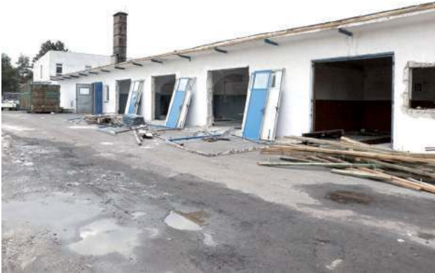
Przebudowa Autodromu w Biłgoraju trwa. Koniec pierwszego etapu to styczeń 2025 roku
