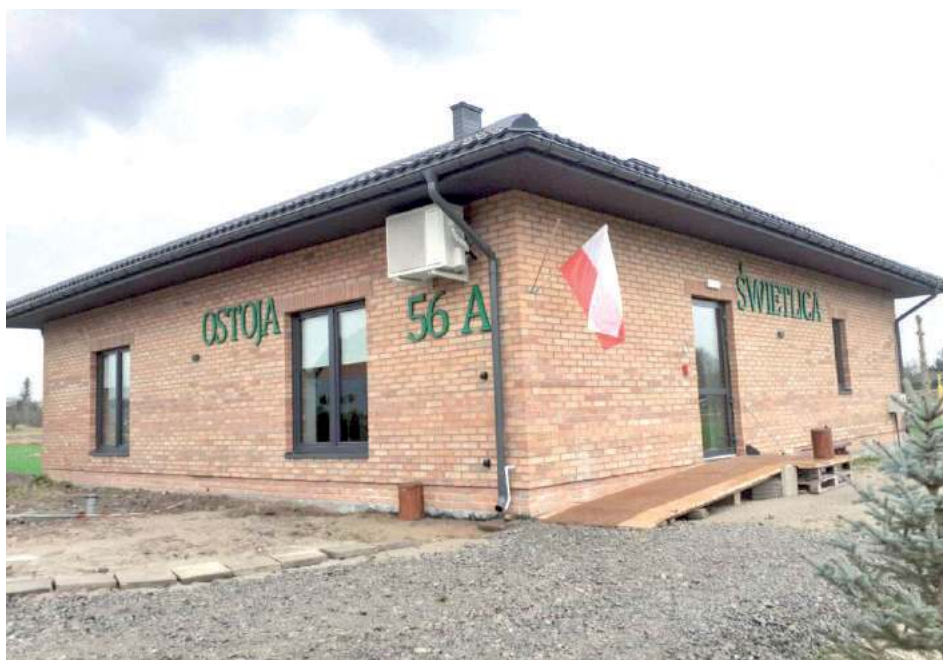
Świetlica wybudowana przez KGW w Olszance już otwarta
