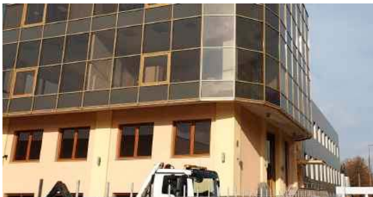
W biurowcu przy al. Lotników Polskich trwają ostatnie prace adaptacyjne. Parter ma zająć CUS, I piętro – Pegimek. W budynku już urzęduje spółka Remondis
