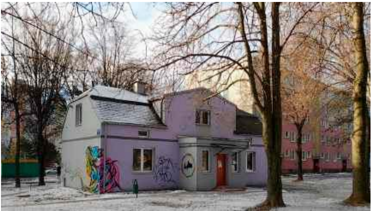
Budynek przy Racławickiej 15d od wielu miesięcy stoi pusty i niszczeje
