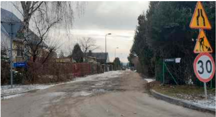
W ubiegłym tygodniu drogowcy zwieźli na ulicę Działkowca część potrzebnych materiałów i oznakowali budowę. Same roboty ruszą lada dzień
