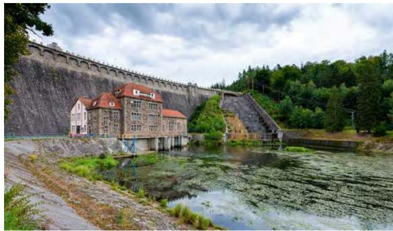
Pilchowice, hydroelektrownia na rzece Bóbr. Foto –Dreamstime
