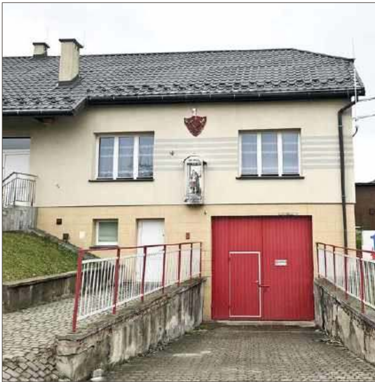
Remiza w Stasiówce jest planowana do remontu.
