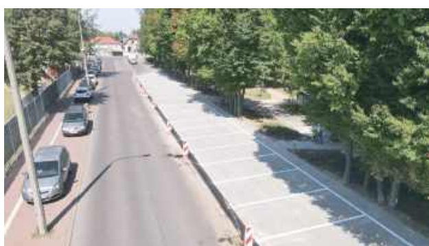
W ramach inwestycji rozebrano zniszczoną nawierzchnię asfaltową
