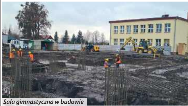
Sala gimnastyczna w budowie
