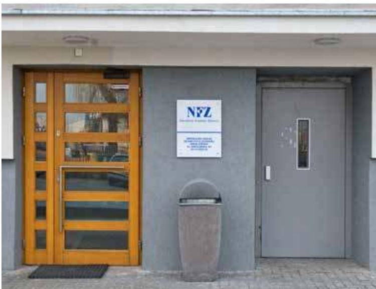
Drzwi do przychodni są zamknięte.
