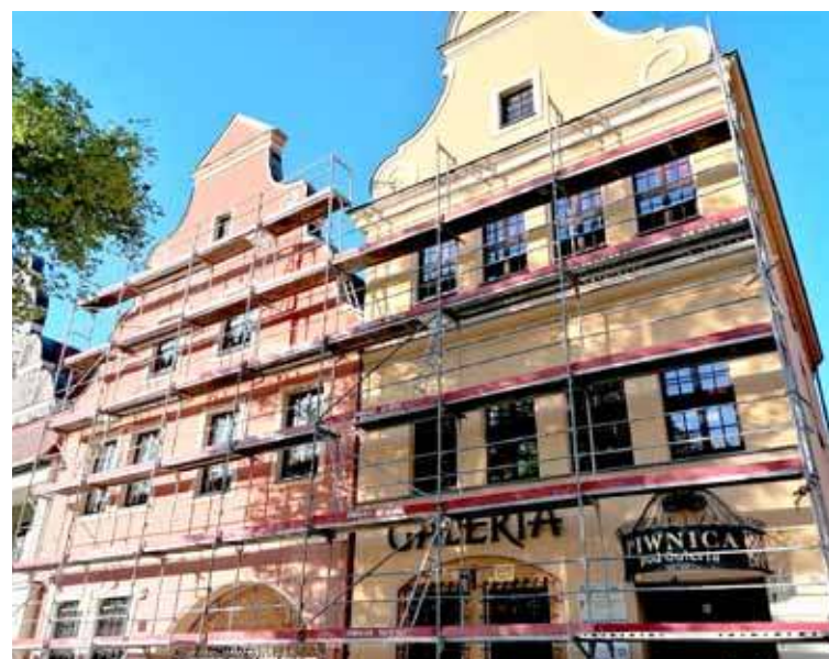
Stargardzkie Muzeum otrzymało środki, dzięki którym możliwe będzie przeprowadzenie remontu na zewnątrz oraz w środku
