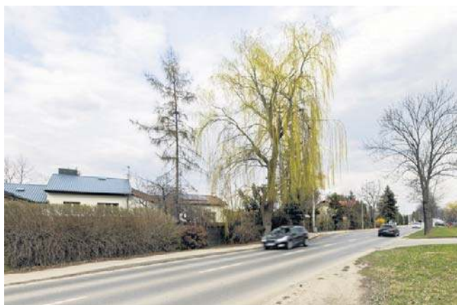
Modernizacja obejmie m.in. zatoki autobusowe i miejsca parkingowe
