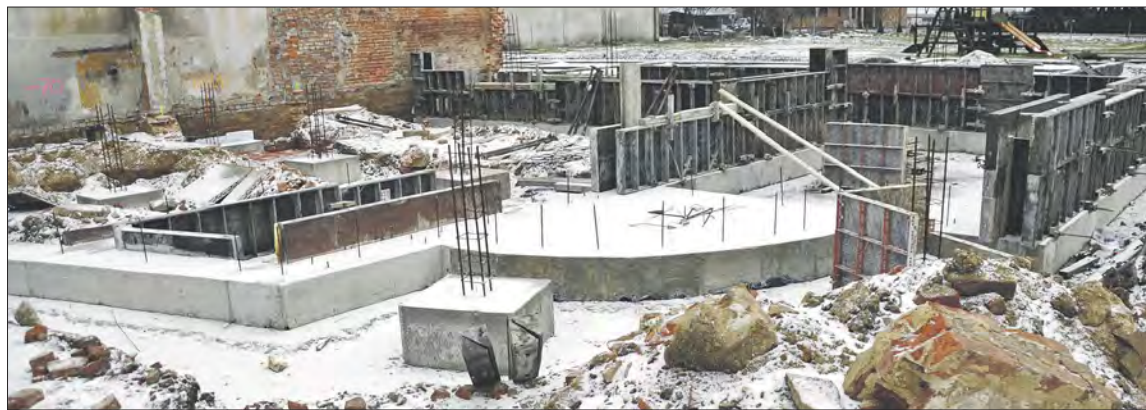
Jak już pisaliśmy, w tegorocznym budżecie Gminy Prudnik zarezerwowano 2,8 mln złotych na kontynuację budowy centrum wiejskiego w Łące Prudnickiej, które obejmować będzie: salę sportową (na bazie istniejące budynku), przedszkole, Wiejski Dom Kultury oraz remizę OSP. Na fotografii aktualny stan prac w części obejmującej nową część obiektu. (d)
