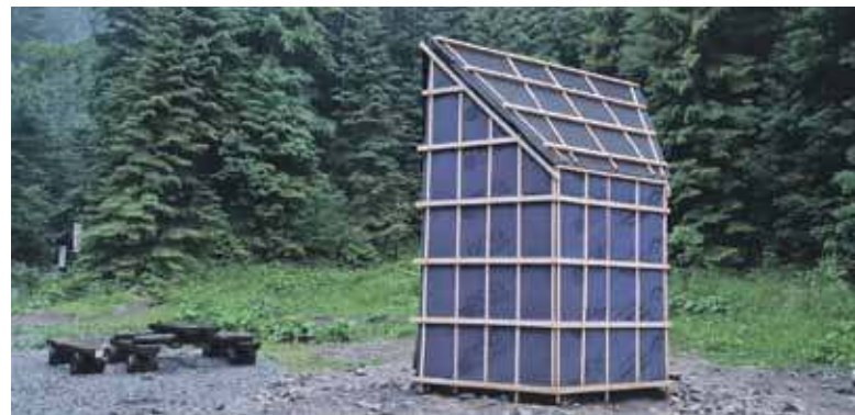
Toaleta w budowie - wylot Doliny Małej Łąki.
