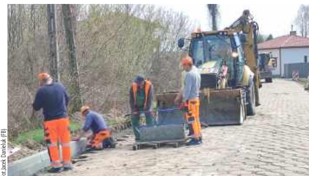
Najpierw na ul. Popiełuszki rozpoczęto oczyszczanie istniejącej nawierzchni z trylinki i układanie krawężników betonowych
