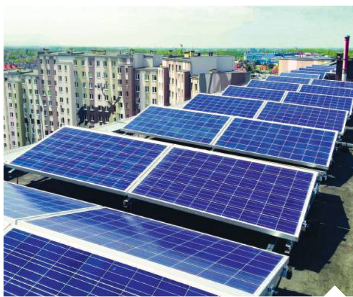
Jesteśmy okradani – twierdzą właściciele instalacji fotowoltaicznych
