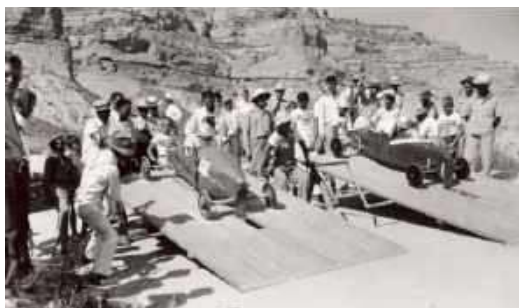
Na zdjęciu z 1939 pokazane jest jedno z rozwiązań ramp startowych z ogranicznikiem kołowym, zwalnianym za pomocą ręcznej dźwigni (fot. https://tiny.pl/h4hy0b7w )
