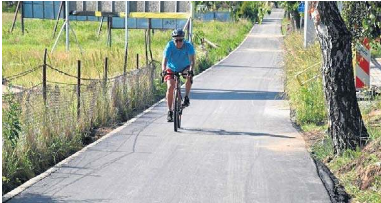
Sękowa dostała grube miliony na ścieżki rowerowe
