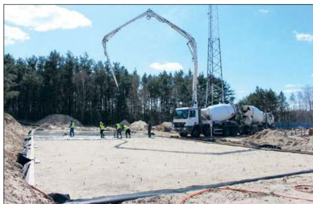
Trwają prace przy budowie Punktu Selektywnej Zbiórki Odpadów Komunalnych (PSZOK) w Kodniu
