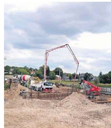
Konieczne było wykonanie pali pod przyczółki mostu
