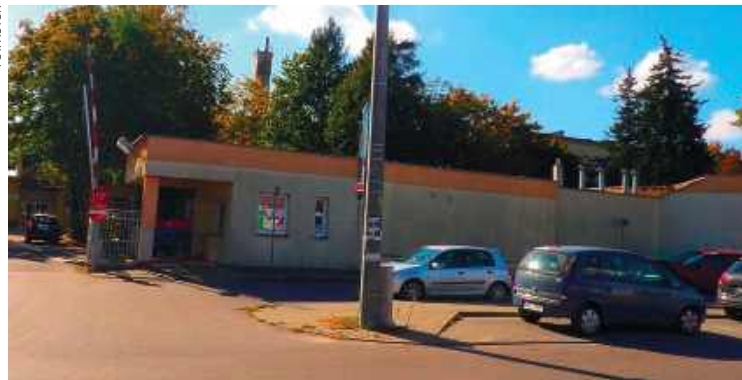
Zrzut oka na budynek szpitala w Mławie. Co prawda nie zbuduje on obiektu dla ZOL
