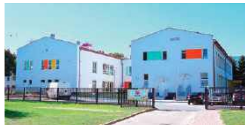
Zmodernizowane przedszkole z dobudowanym skrzydłem
