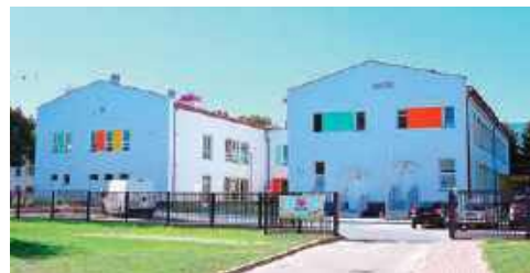
Zmodernizowane przedszkole z dobudowanym skrzydłem
