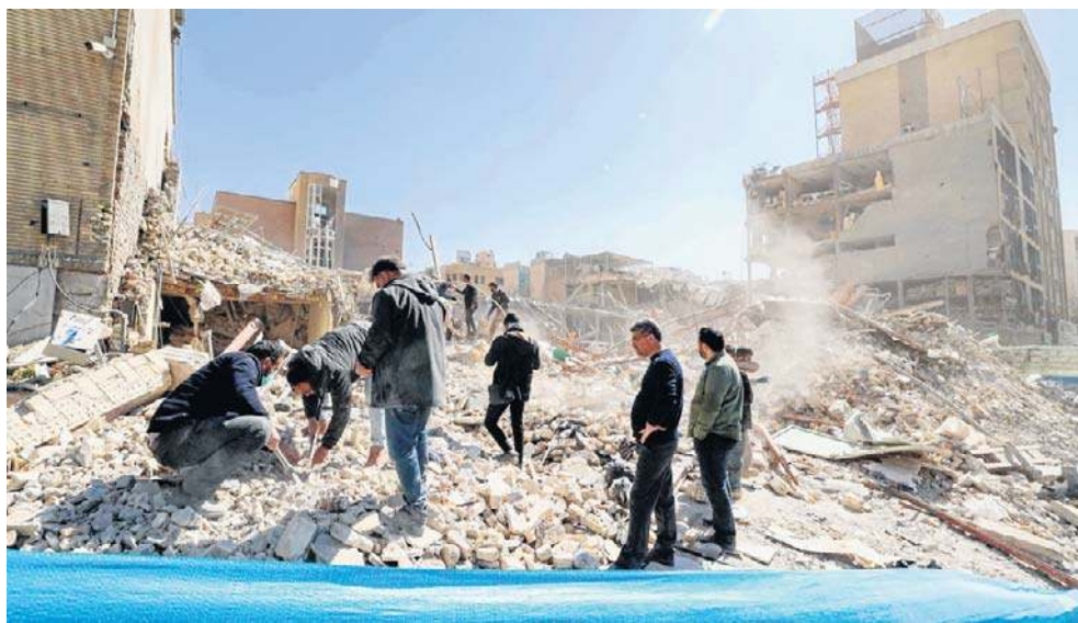
Ludzie oglądają gruzy zavalonego budynku w pobliżu placu Ferdousiego w Teheranie. Ataki Izraela i Stanów Zjednoczonych na Iran trwają od 28 lutego
