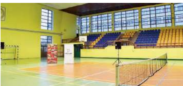
W końcu hala doczeka się remontu.
