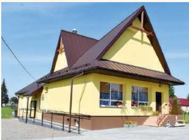
Świetlica wiejska w Husynnem.
