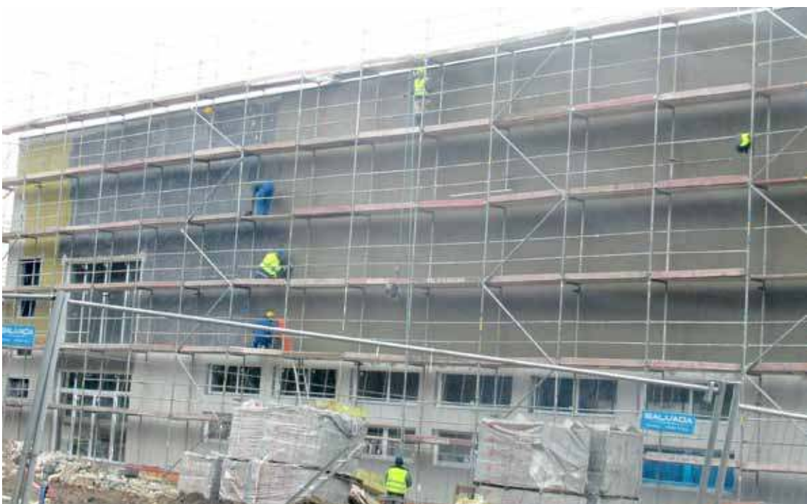
Plac budowy 4 lutego br
