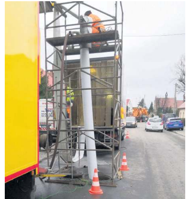
Obecnie trwa renowacja kanałów przy ul. Staromiejskiej w Strzelinie
