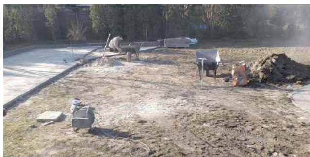
Prace przy tworzeniu podwórka idą pełną parą
