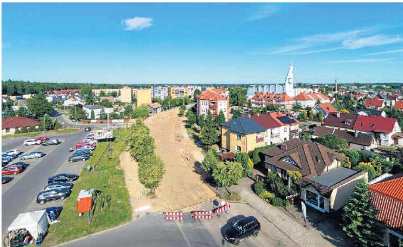
Widać postępy prac na ul. Reja. Tymczasem kierowcy apelują o ostrożność.
