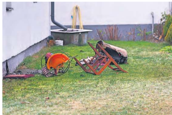
Pożar zaczął się w kotłowni domu jednorodzinnego.
