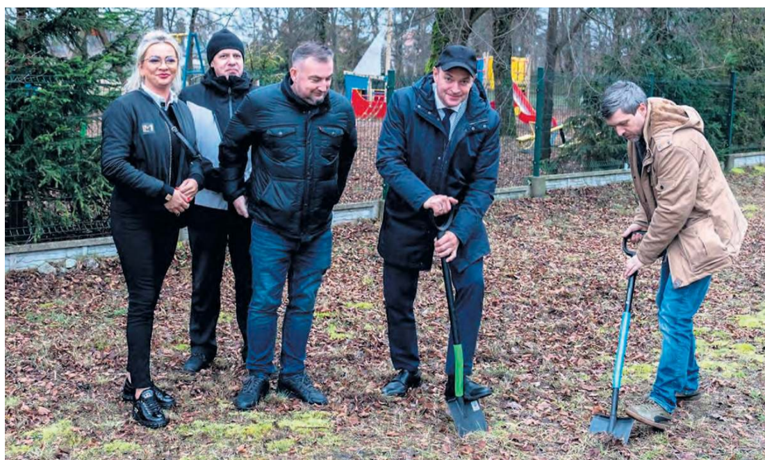
Prace przy budowie żłobka będą musiały postępować szybko. Według założeń wielomilionowe zadanie ma zakończyć się do 29 maja 2026 roku. Fot. UG Śliwice
