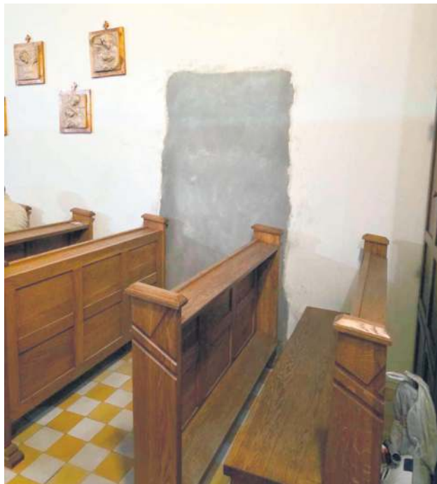
Wewnętrzne drzwi zostały zamurowane w marcu.
