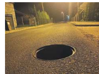
Ul. Centralna w Myślachowicach. W zeszłym miesiącu złodzieje zrabowali w tej okolicy kilka włazów do studzienek
