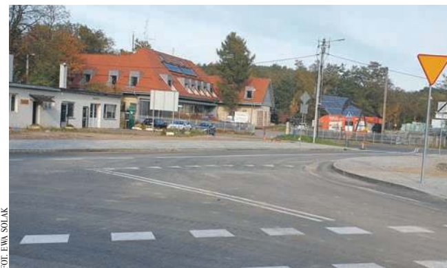
Drogi w strefie są gotowe
