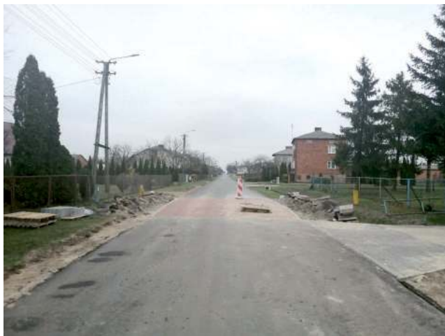
Droga biegnąca przez Sielce zyskała już nową nawierzchnię
