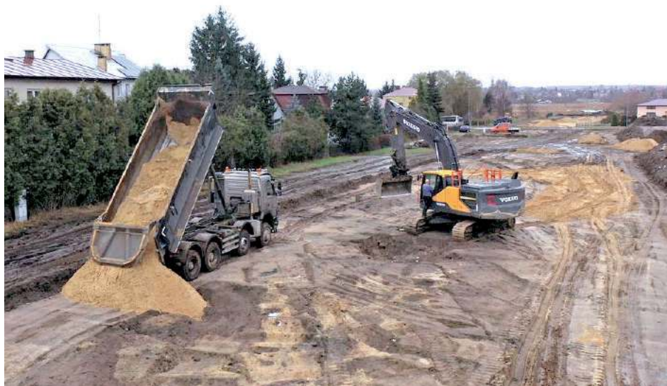
Ruszyła budowa mostu i dróg dojazdowych do niego
