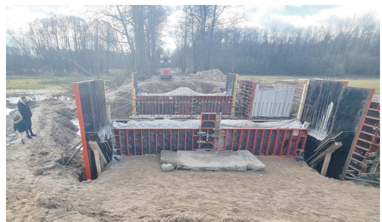
Przebudowa mostu na rzece Ugoszcz
