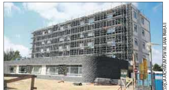
Na placu budowy zakończono prace stanu surowego. Aktualnie trwają prace elewacyjne, instalacyjne oraz wewnętrzne prace wykończeniowe
