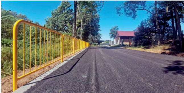
Nowy asfalt przy ulicy Floriana
