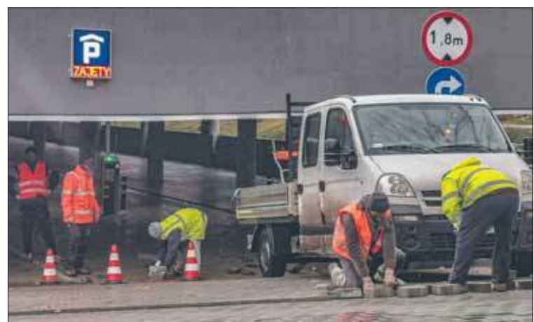
Na parkingu trwają kolejne prace modernizacyjne
