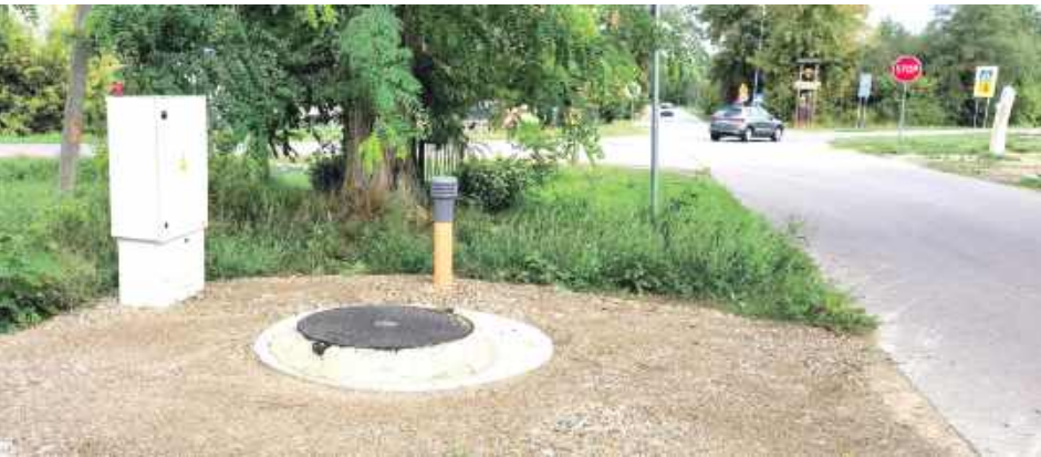
Zadanie wykonała firma Parster Sp. z o.o., odbiór prac odbył się 13 sierpnia
