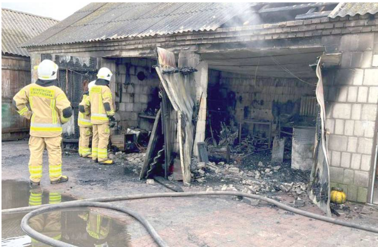
Spłonęło wyposażenie garażu. Na miejscu pracowały trzy zastępy straży pożarnej
