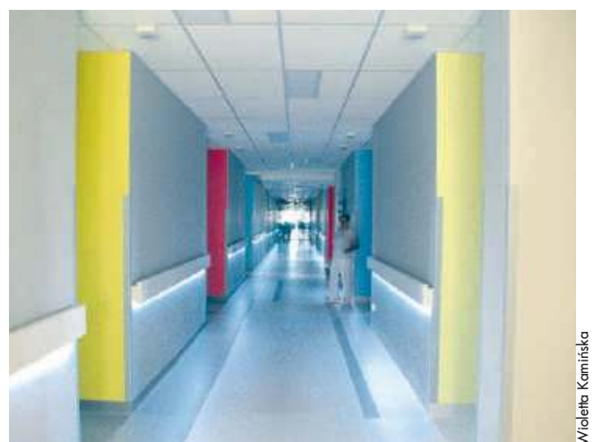
W 2019 roku wyremontowano oddział chirurgiczny olawskiego szpitala. Teraz niezbędny jest remont oddziału wewnętrznego, który jest w bardzo złym stanie
