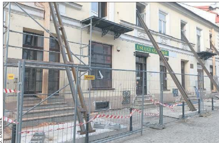
Przy remontowanej kamienicy przy ul. Grodzkiej 8 stanęły zabezpieczające podpory
