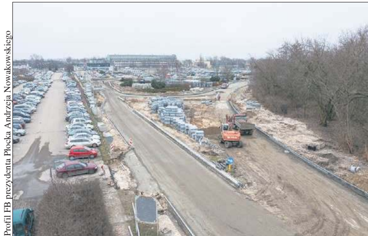
Prace na ul. Łukasiewicza w okolicach bramy nr 2 koncernu petrochemicznego
