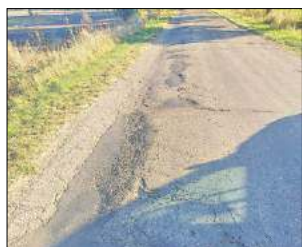
1,96 mln zł sfinansuje przebudowę drogi powiatowej nr 2013W Ostromęczyn – Nowa Kornica na odcinku od drogi krajowej nr 19
