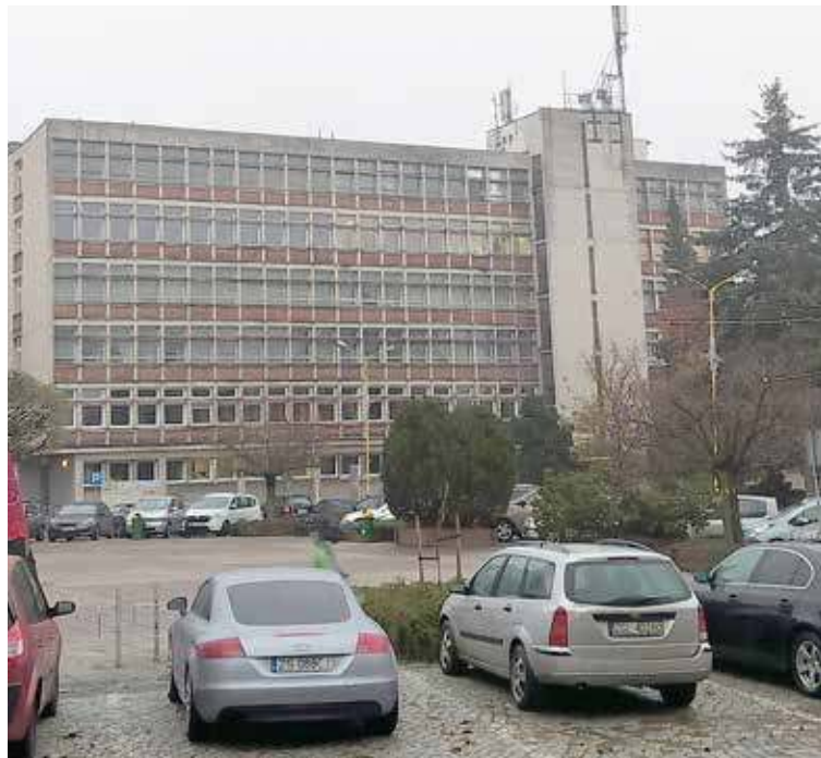
Jedyny w całej gminie czujnik zamontowany został w budynku Cisy przy Placu Wolności
