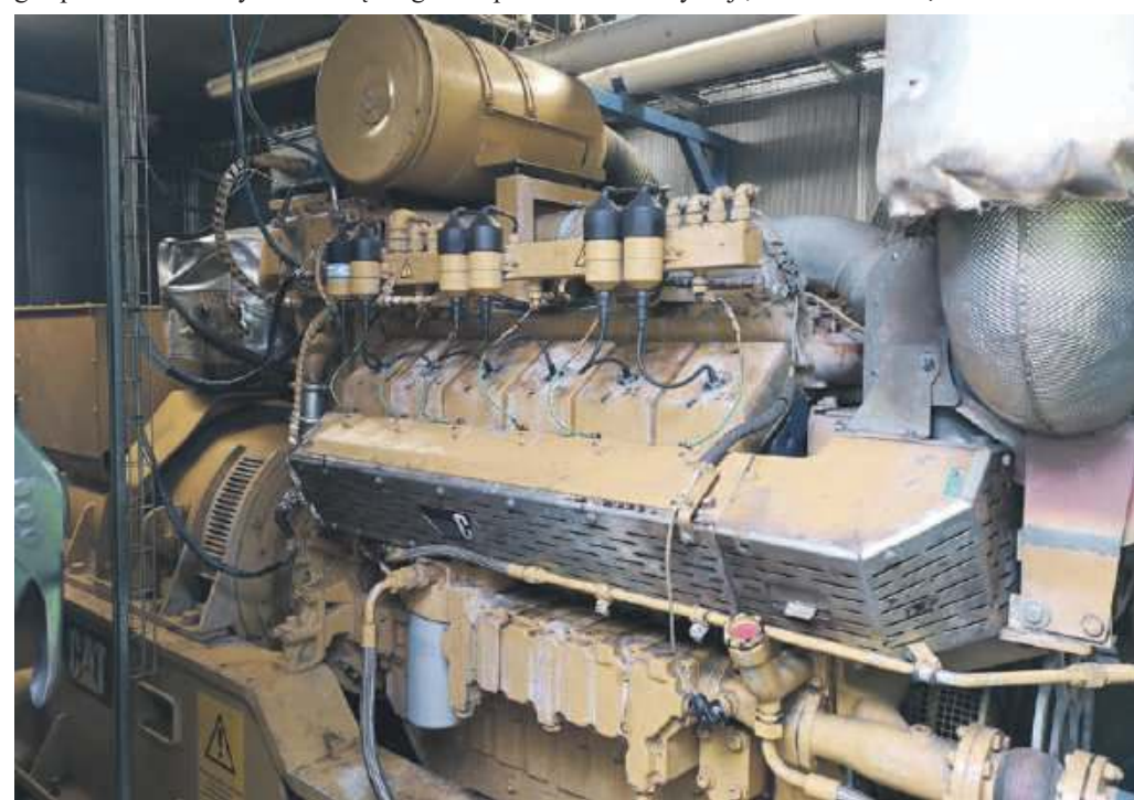
Tu są dwie jednostki kogeneracyjne, czyli silniki gazowe, sprzężone z turbiną elektryczną, produkującą prąd
