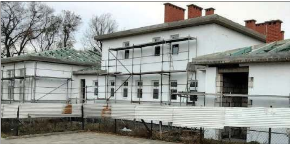
Po trwających niespełna rok pracach bryła budynku jest już prawie gotowa. Teraz ekipa zaniera się za dach
