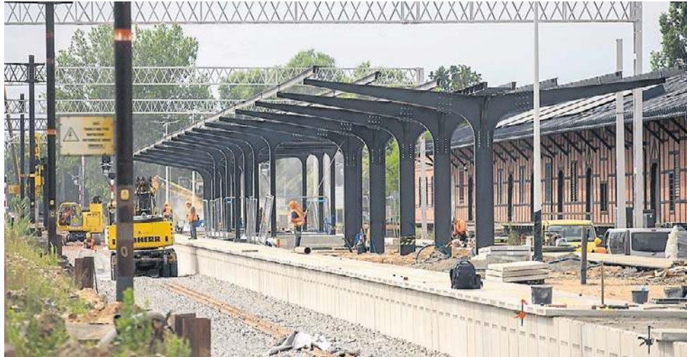
Trzeci peron na stacji Słupsk ma być gotowy we wrześniu
