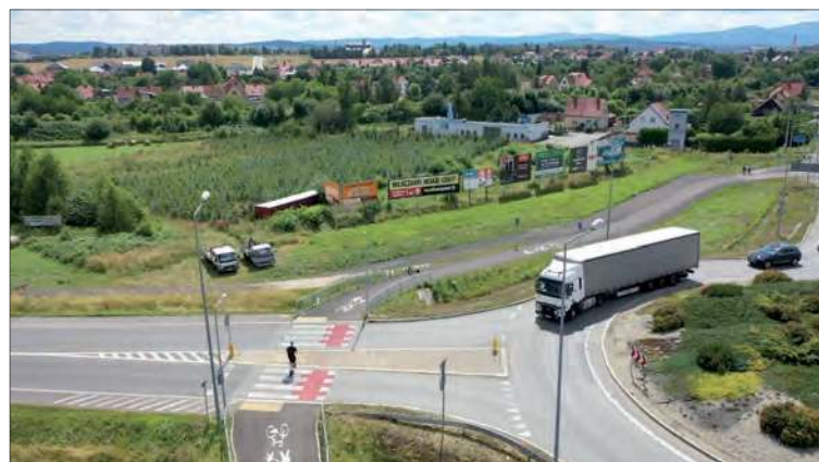
Przejście posłuży nie tylko klientom galerii handlowej, ale usprawni również komunikację między Prudnikiem a Lubrzą
