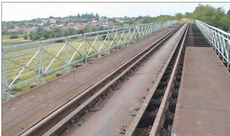
W ramach inwestycji odnowiony zostanie potężny most kolejowy w Raclawicach Śląskich
